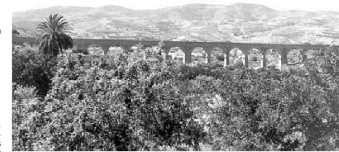
CONSTRUCCIÓN DE INTERÉS DENTRO DEL CAMPO DE CARTAGENA / CAMPODER
